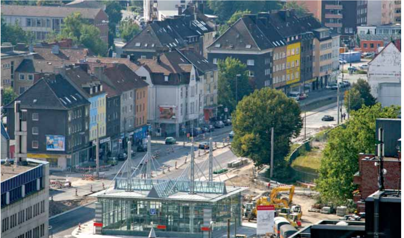
Die Rheinische Straße zwischen Wall und Möllerbrücke ist noch eine Baustelle. Die neue U-Bahn Station steht aber schon. Nach dem Umbau soll die Rheinische Straße in beide Richtungen befahrbar sein. Foto: Gesine Lübbers
