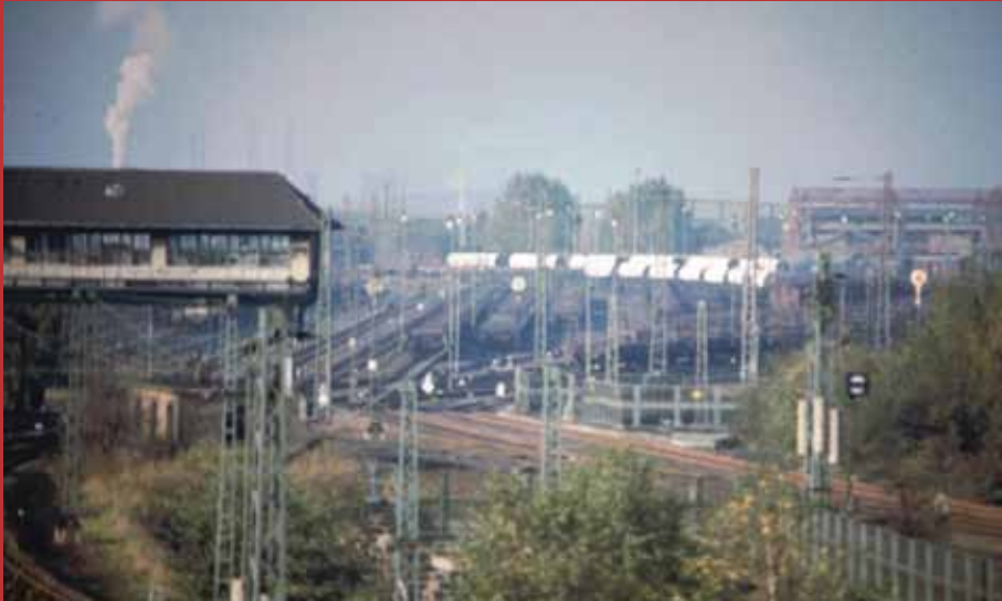
Blick auf den Rangierbahnhof Dortmunder Feld von der Schnettkerbrücke ca. 1960
