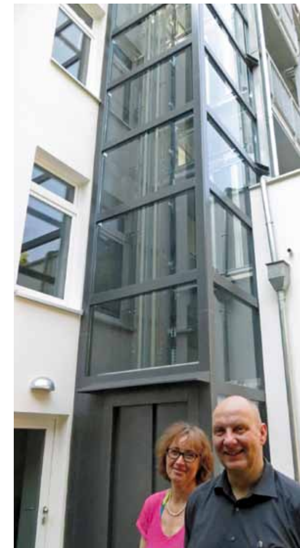
Angelika und Andreas Benesch haben mit dem Aufzug gleich zwei Altbauten altersgerecht gemacht. Fotos: Gesine Lübbers
