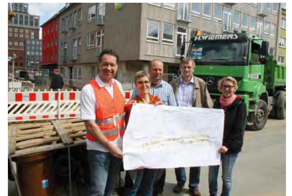
Bis mindestens Jahresende bleibt die Lange Straße eine Baustelle (Fotos oben), doch Michael Quandt, Dorit Gloth, Dietmar Anhalt, Ulrich Stein und Ina Bahr wissen, wie die Straße dann später aussehen wird. Fotos: Gesine Lübbers
