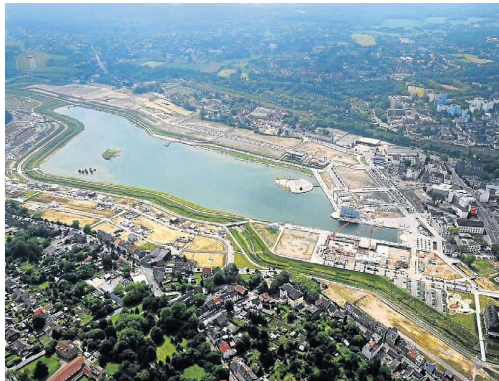
2012: Seit April dürfen Segel- und Ruderboote auf den See. Die Wasserqualität ist hervorragend und in Promenadennähe laufen die Bauarbeiten auf Hochtouren.
