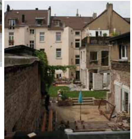
Umfassende Abbruch- und Aufbauarbeiten an der Richardstraße schafften Raum für Spiel- und Ruhezonen für alle Bewohner des Hauses. Fotos: Tabea Sieben
