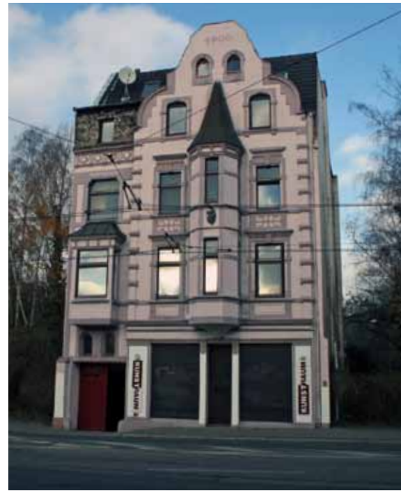
Am westlichen Ende der Rheinischen Straße steht das markante Haus 231a.
