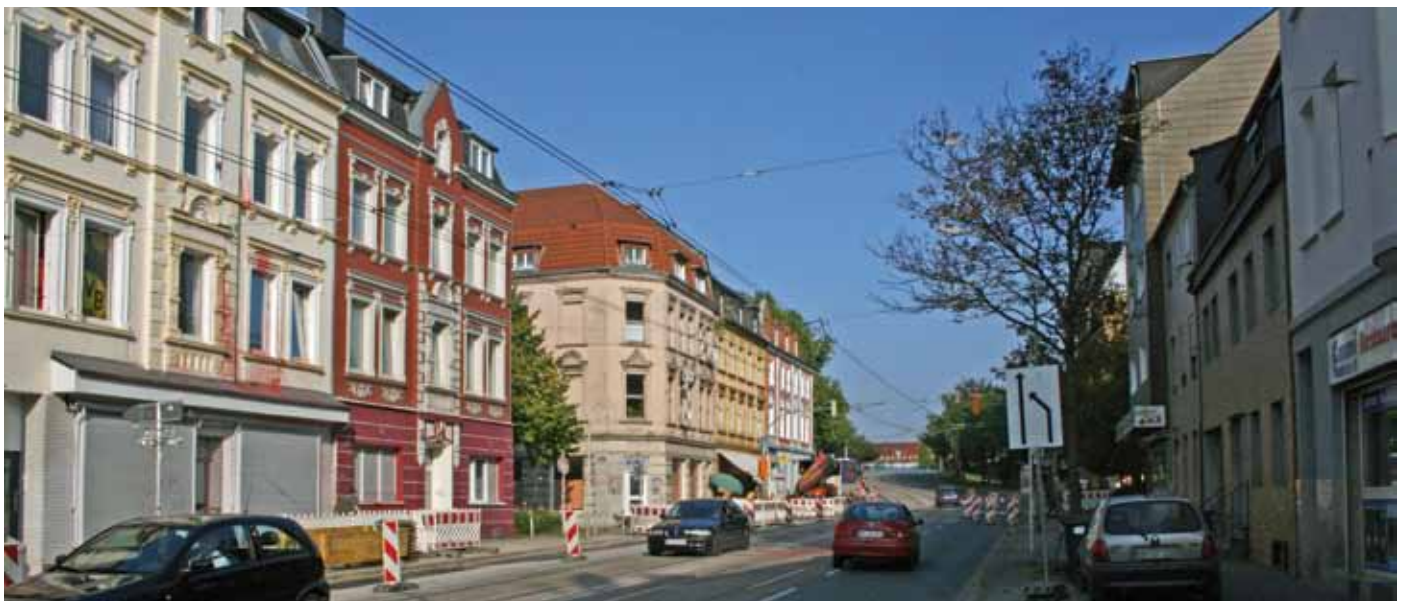
Derzeit werden auf dem westlichen Stück der Rheinischen Straße die Kanäle und Versorgungsleitungen erneuert – 2014 könnte die komplette Straße umgestaltet werden. Foto: Gesine Lübbers
