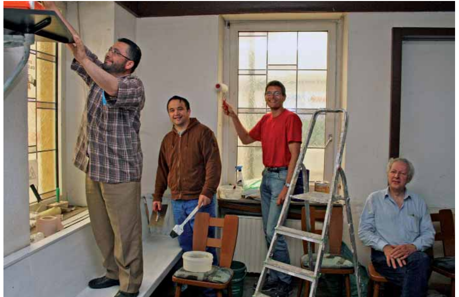
Im ehemaligen Treppchen gibt es viel zu tun.
